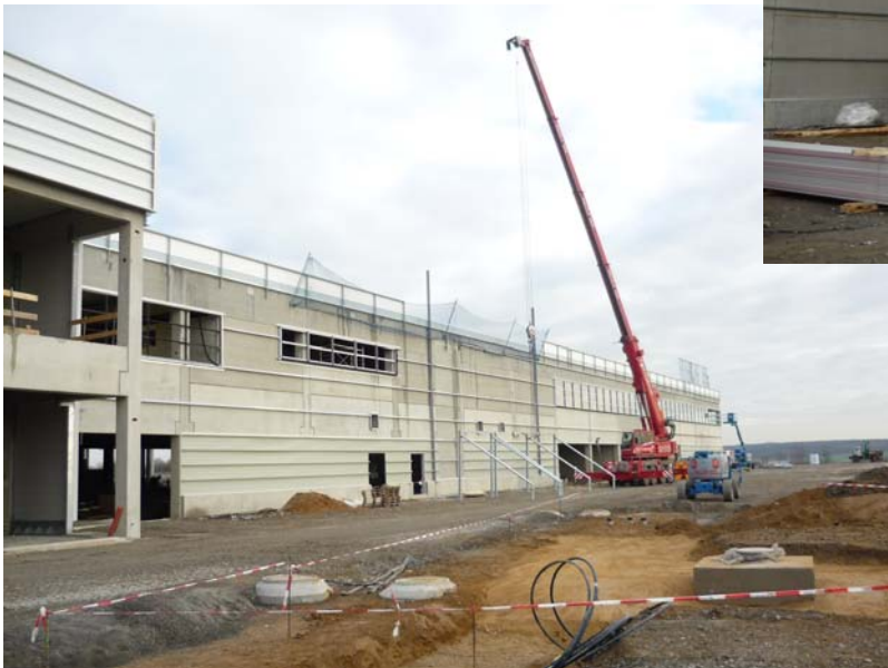
Vorderseite (rechts ist der Eingang)
